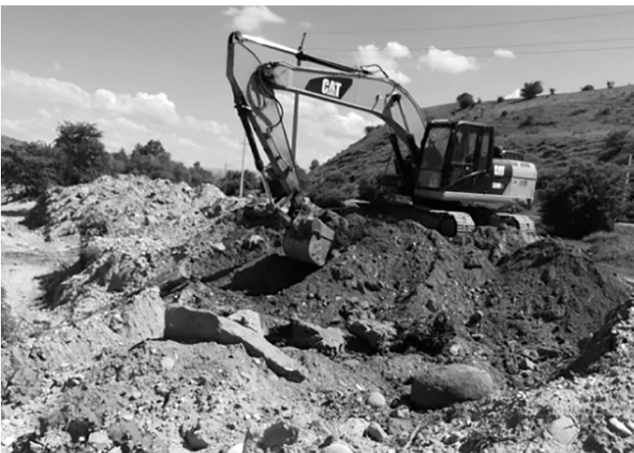
Реконструкция моста идет полным ходом
